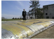
Промышленное испытание гибкой дамбы в г. Крымске
