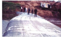
Гибкая дамба, перекрывающая канал Варнавинского водохранилища
